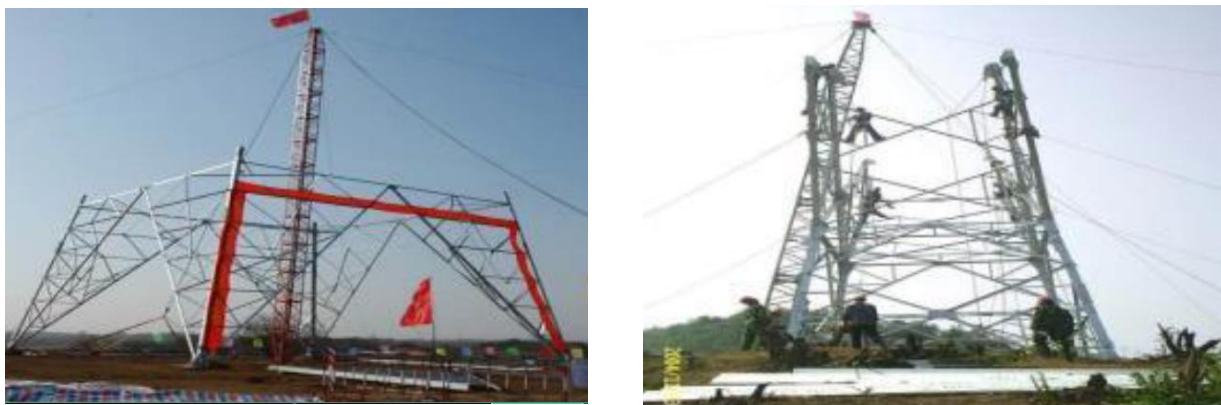
图 1-1 类似线路工程铁塔组装现场图
