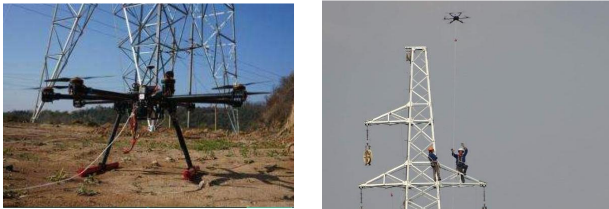
图 1-2 类似线路工程无人机展架线现场图
