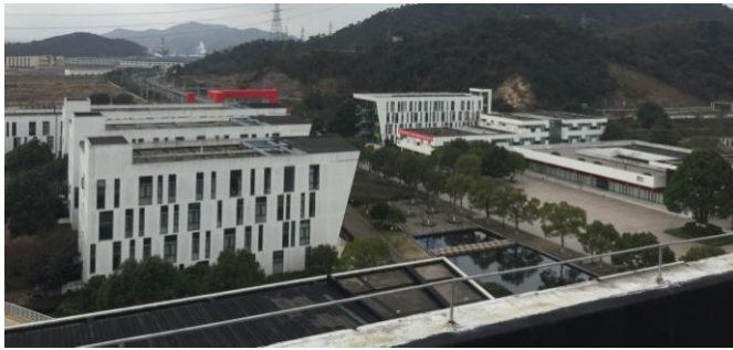
图 1.5-2 厂前区屋顶现状
