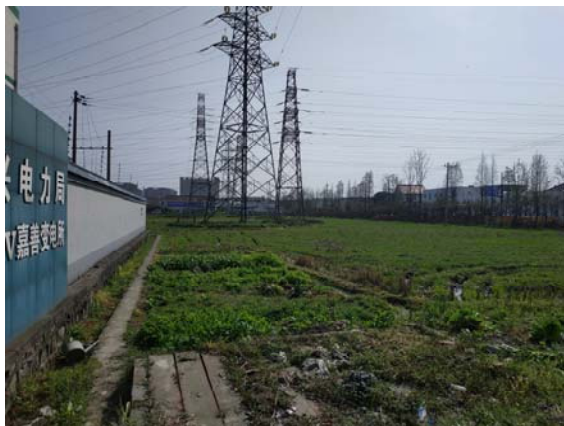
220kV 嘉善变电站区域
