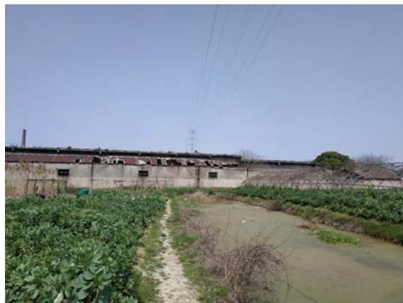
220kV 嘉铁 2P57 线、善铁 2P58 线
