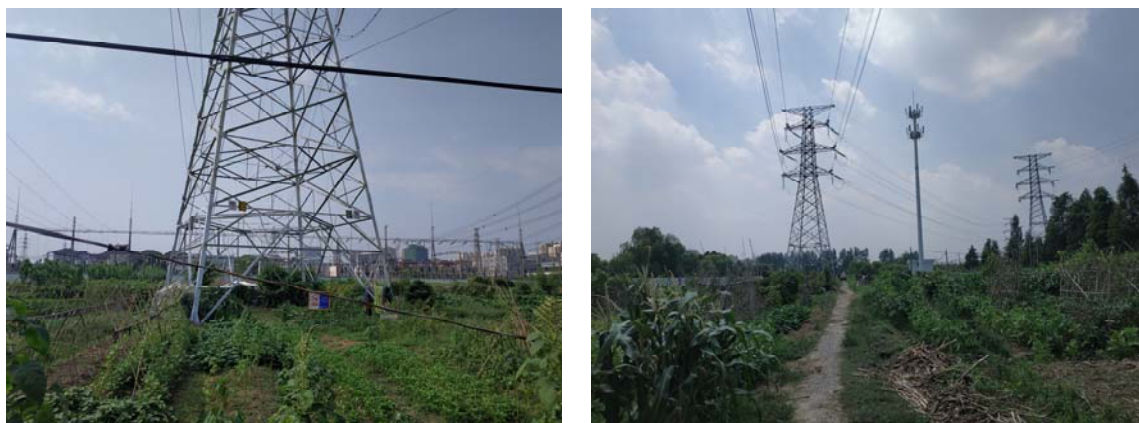
220kV 线路工程区域
