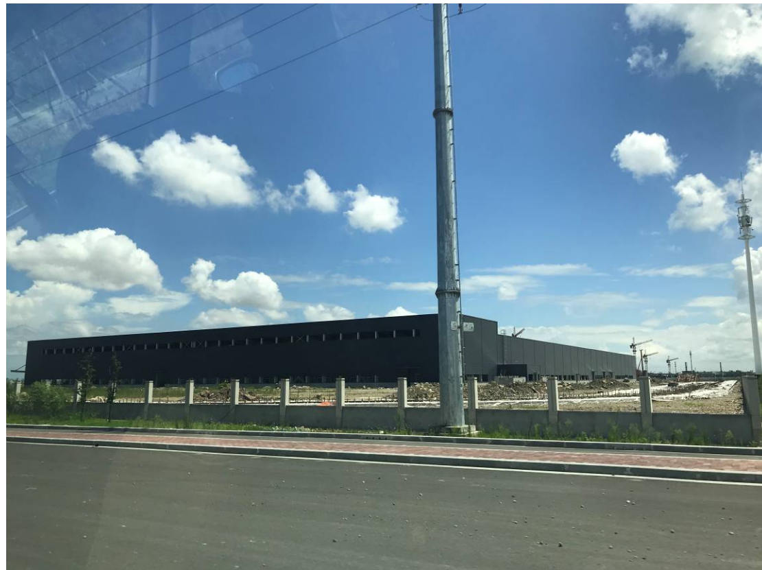
山涂变西南侧在建厂房
