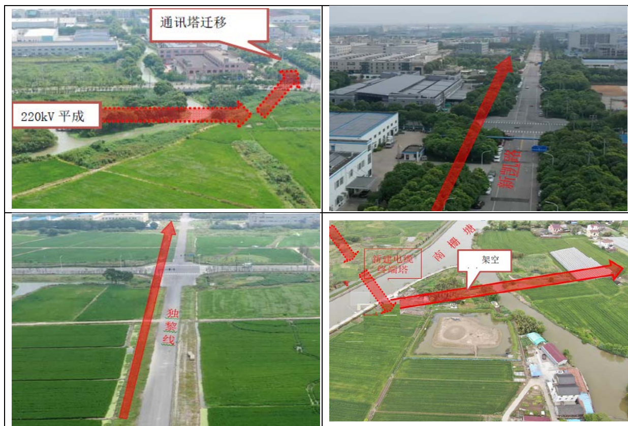
图 1.1-2 线路工程沿线现状照片
